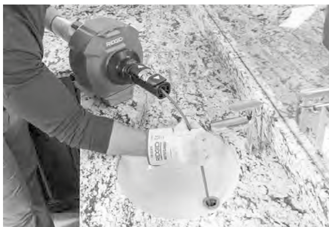
Figura 14 – Avançar o cabo manualmente
