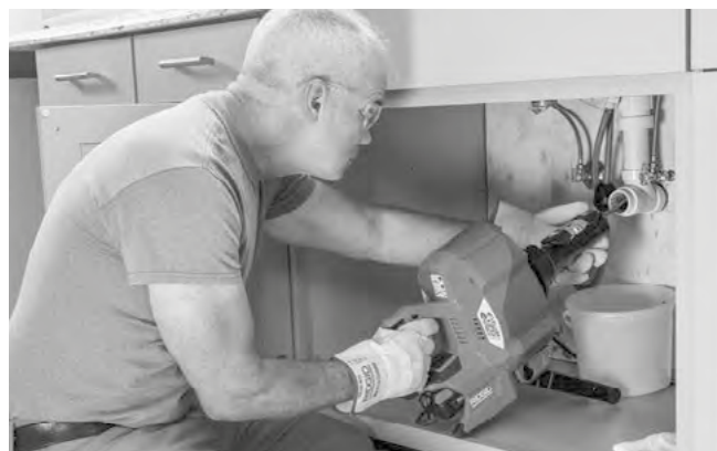
Figura 13 – Empurrar o cabo com unidade AUTOFEED
